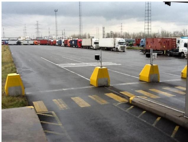
I sigilli RFID si leggono con **antenne** ed **unità elettroniche intelligenti (lettori RFID)** che nel loro insieme costituiscono un **VARCO RFID**.
